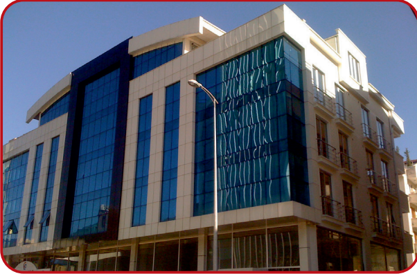
Elektromekanik Merkez Bina (Elektromekanik General Office) Antalya
