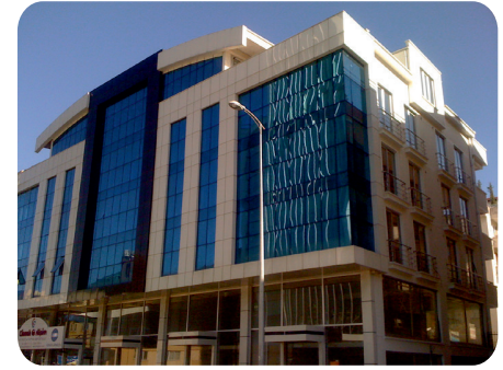
Elektromekanik Merkez Bina (Elektromekanik General Office) Antalya
